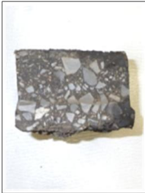
舗装路片の 断面写真
