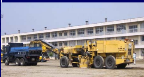
③ 道路切削機（ロードカッター）
