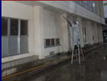
高圧洗浄による除染
