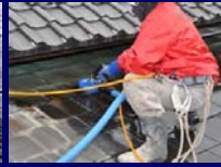
屋根部分を吸水式の高圧洗浄機、ブラッシング
