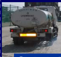
① 水を散布（飛散防止）
