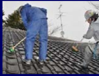
屋根部分を吸水式の高圧洗浄機、ブラッシング
