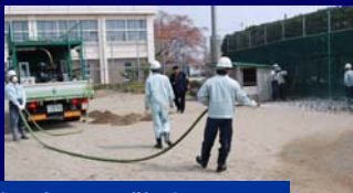
① 水を散布（飛散防止）
